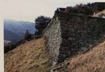
つるぎ町・一字明谷の石垣。民家基盤の高度な反りを持つ高石垣だ。
